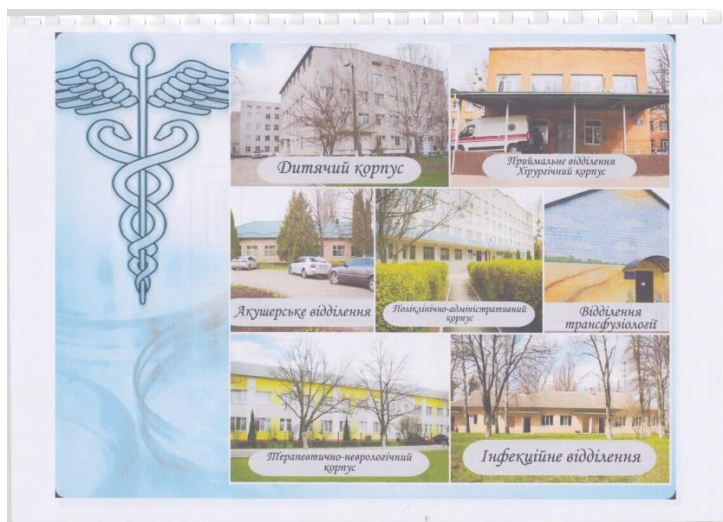
Рисунок 1.1 – Загальний вигляд об'єкту енергоаудиту
