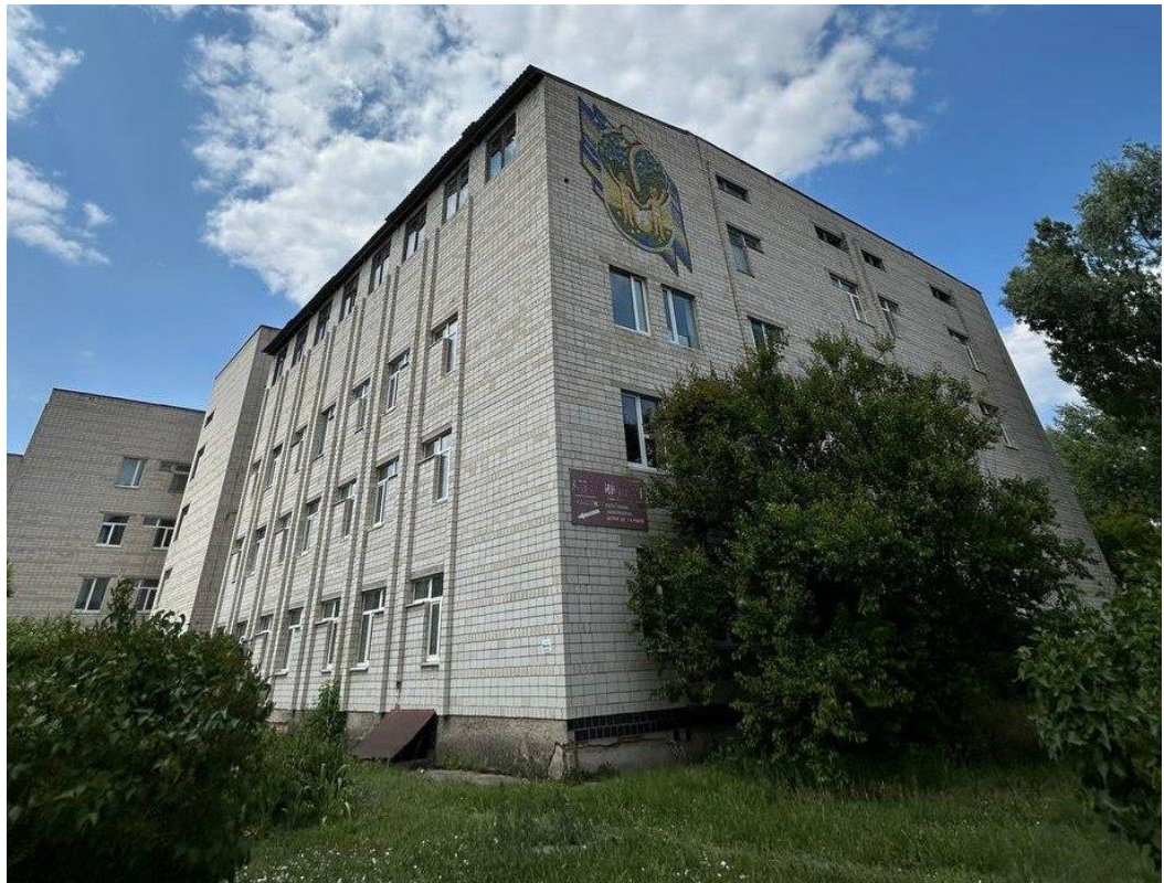
Рисунок 1.3 – Зовнішній вигляд фасаду
