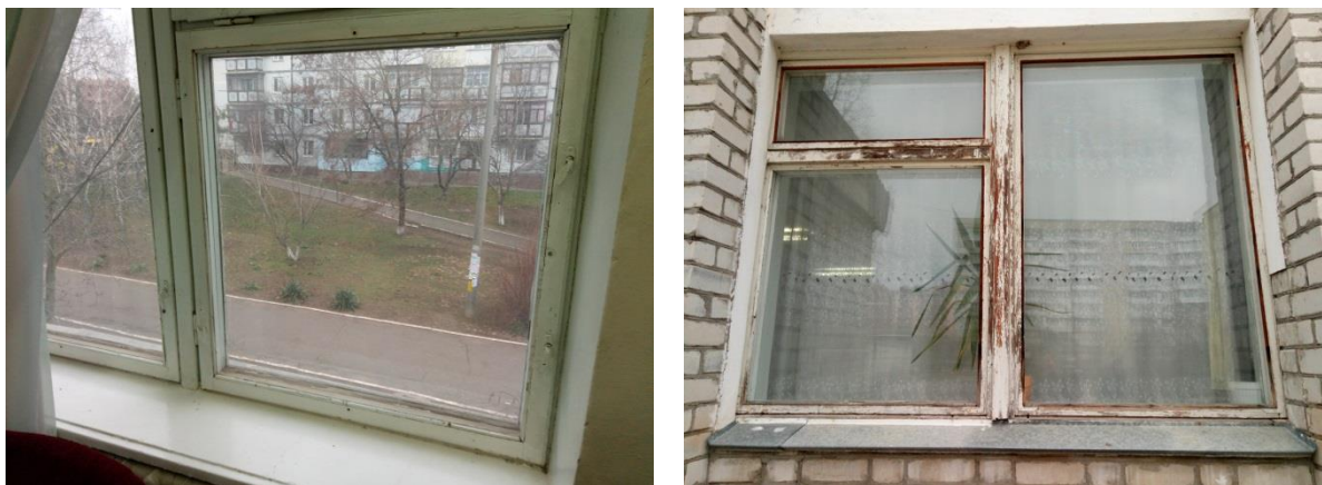
Рисунок 1.3 – Загальний вигляд віконних конструкцій будівлі
