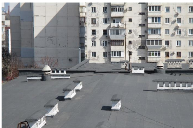
Рисунок 1.5 – Загальний вигляд покрівлі будівлі
