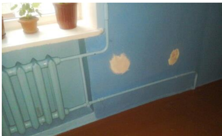
Рисунок 1.7 – Зовнішній вигляд чавунних секційних радіаторів
