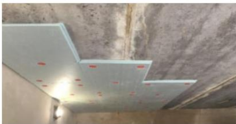
Рисунок 3.7 – Накладання теплоізоляції на перекриття
