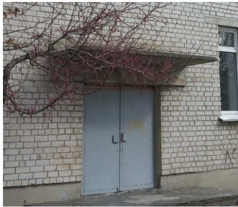
Рисунок 3.4 – Зовнішні металеві двері
