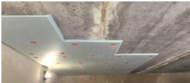
Рисунок 3.3 – Схема утеплення перекриття над підвалом
