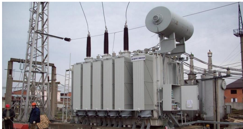
Рисунок 2.7 – Трансформатор ТДН-40000/110-70
