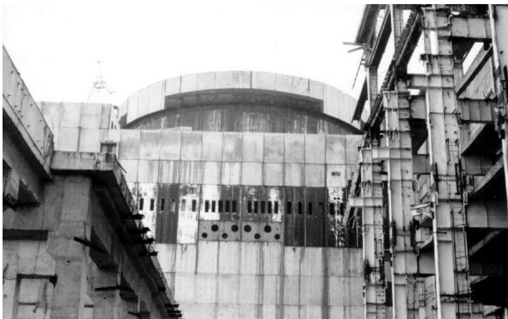
Рис. 3. Современное состояние обстройки реактора
