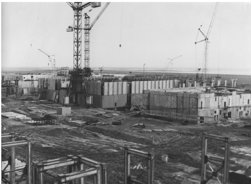
Рис. 1. Строительство Крымской АЭС
