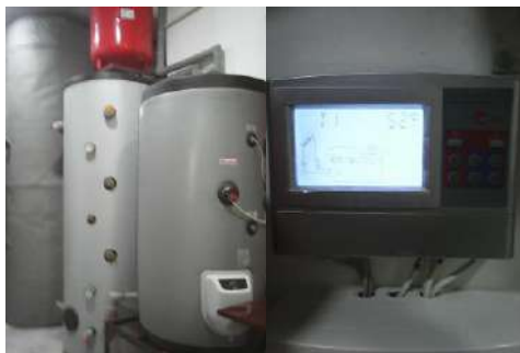
Рис. 5. Котельня ПДГ №1: Електрокотел, водяний ТА і система ГВП від СК з пультом праворуч.
