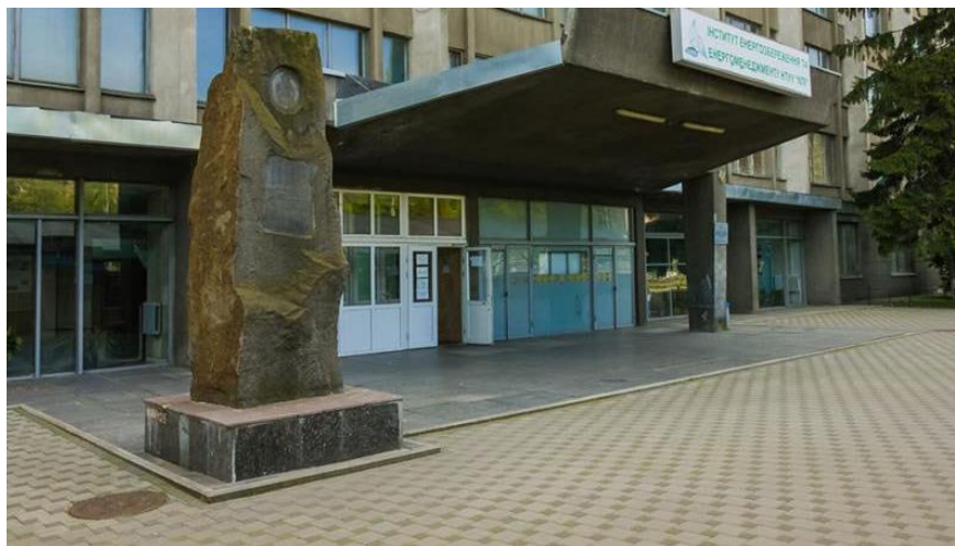
Рисунок 2.3 – Відсутність пошкодження облицювання зовнішніх стін
