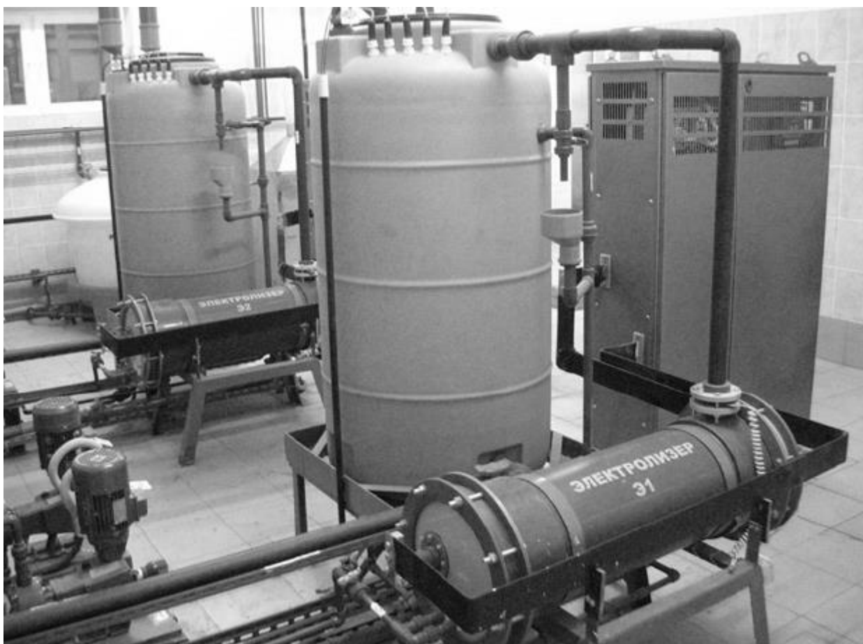
Рис. 1.3.2 Установа для одержання водню електролізом води
