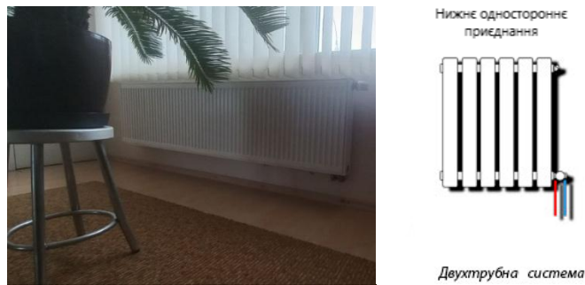
Рис. 2.5 – Сталеві радіатори з нижнім підключенням
