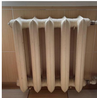
Рис. 2.6 – Чавунний радіатор другої половини будинку
