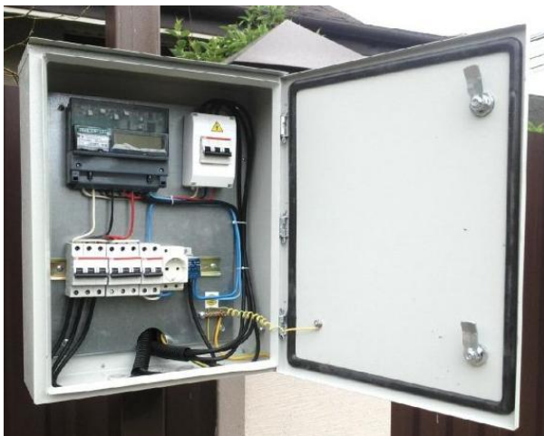
Рисунок 2.11 – Ввідна шафа другого вводу
