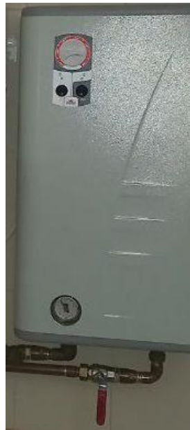
Рис. 2.2 – Резервний електричний котел
