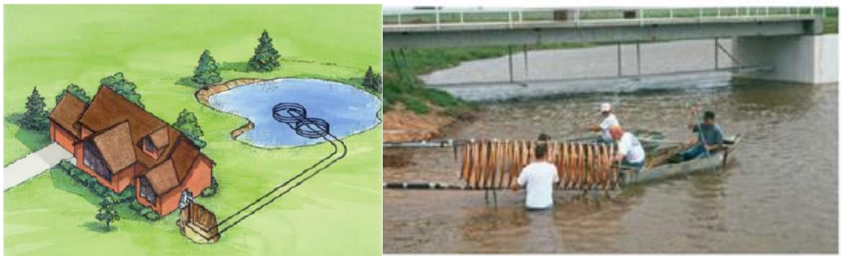
Рисунок 1.15- Системи теплових насосів на поверхневих водах
