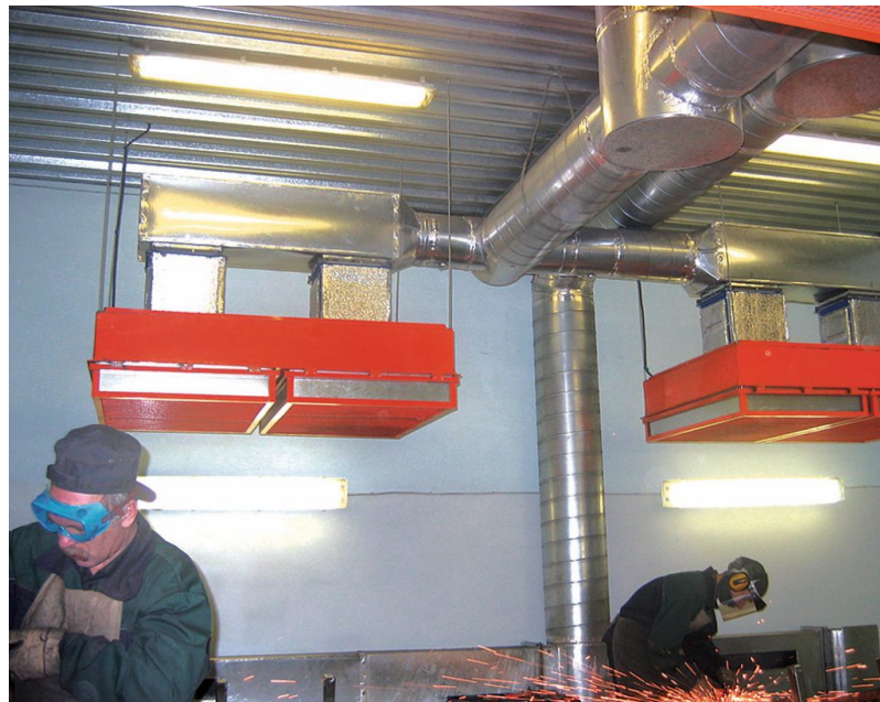
Рисунок 3.79 - Приклад місцевої вентиляції [33]
