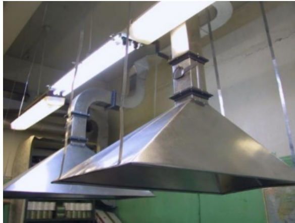
Рисунок 3.80 - Приклад місцевої вентиляції [34]
