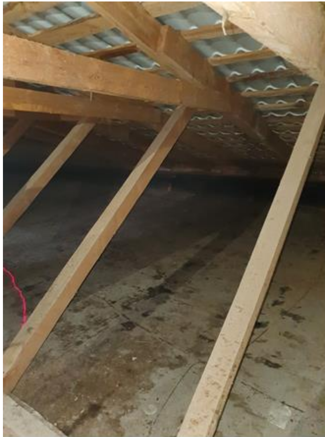
Рисунок 2.2 – Дерев'яні конструкції даху
