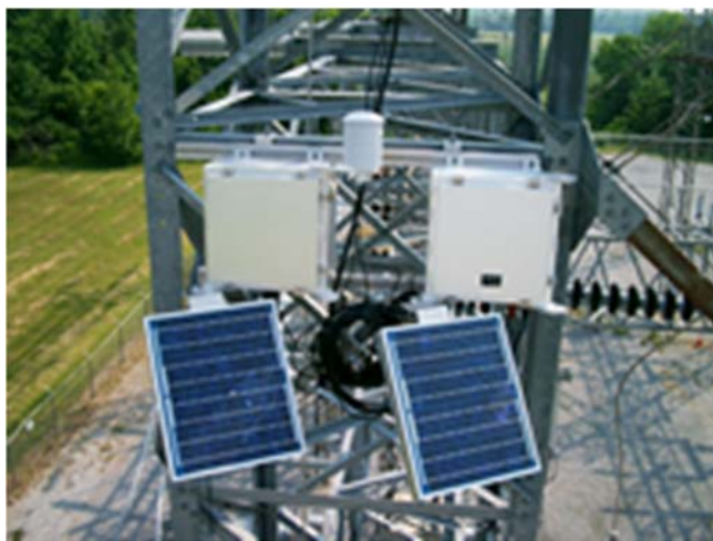
Рис.4.3 - Система моніторингу проводів САТ-1
