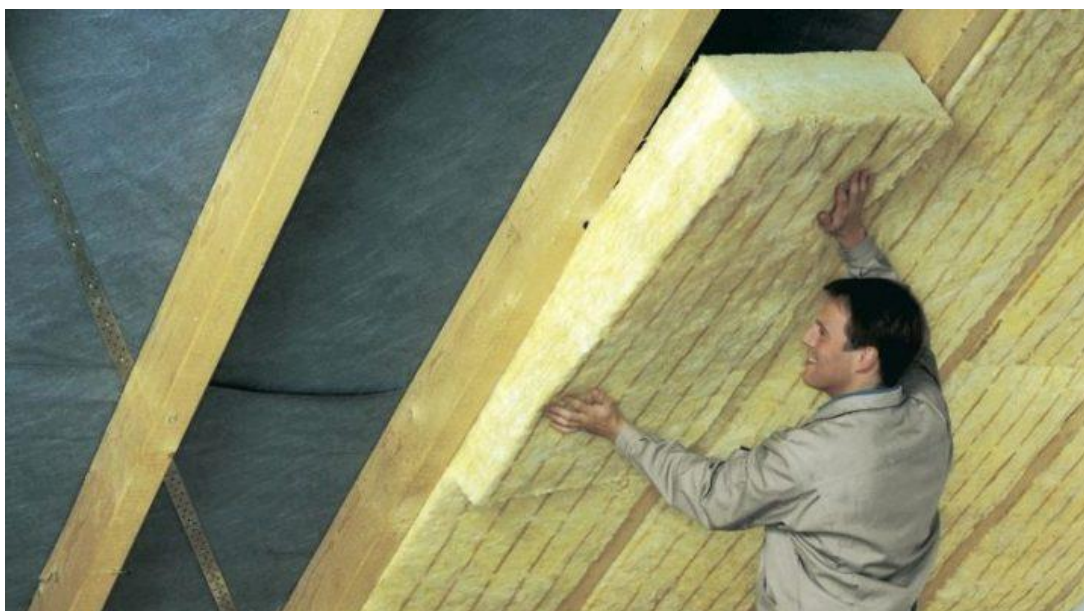
Рисунок 3.9 – Приклад утеплення мінеральноватними плитами
