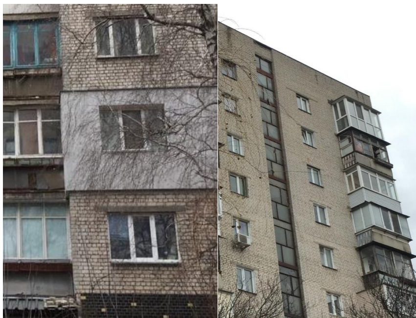
Рисунок 3.1 – Фото зовнішніх стін
