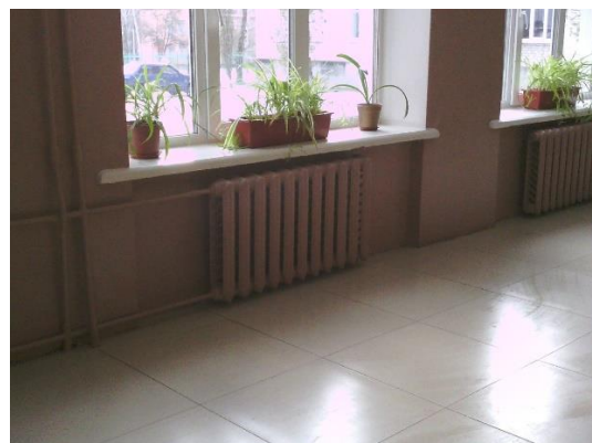
Рисунок 2.12 – Радіатор М-140:
