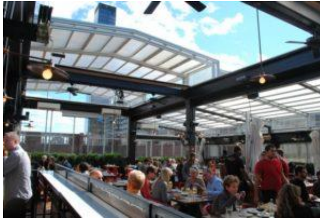
Рисунок 1.9 - Система рухомого даху для ресторану
