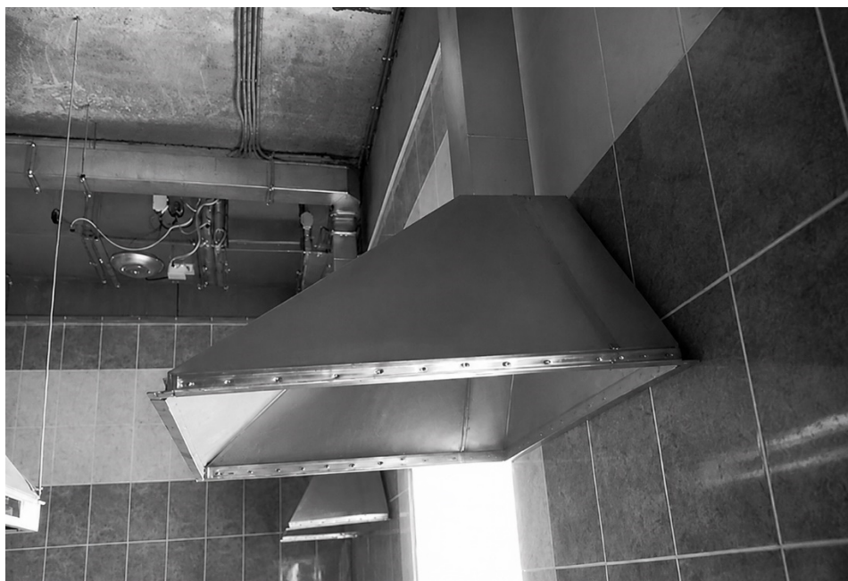
Рисунок 2.2. — Панель місцевого відсмоктування від вулканізаційного преса [40]
