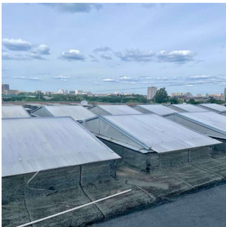
Рисунок 3.1 – Встановлені зенітні ліхтарі на даху будівлі 1 типу
