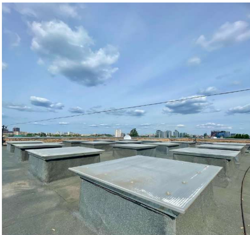
Рисунок 3.2 – Встановлені зенітні на даху будівлі 2 типу
