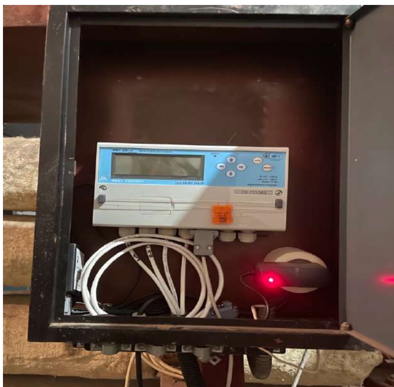
Рисунок 1.9 – Теплообчислювач МВТ – 2М нк .
