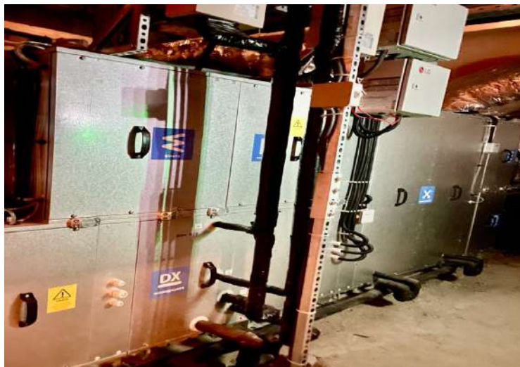
Рисунок 1.3 – ПБУ з рекуперацією тепла, шелтер CLUST Space
