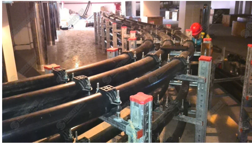
Рис. 5.1. Загальний вигляд трифазної кабельної лінії
