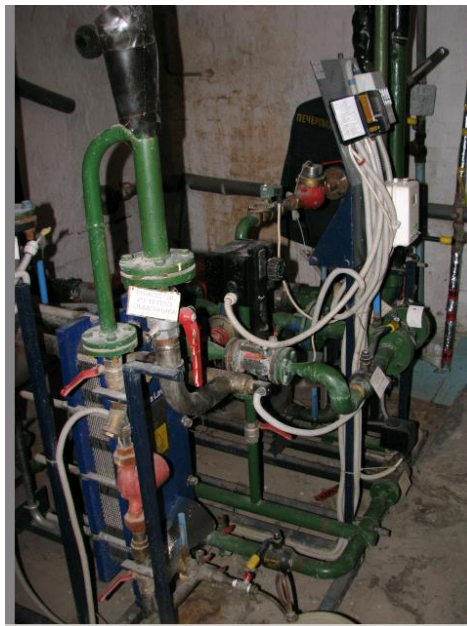
Рисунок 3.2 – Тепловий пункт будівлі
