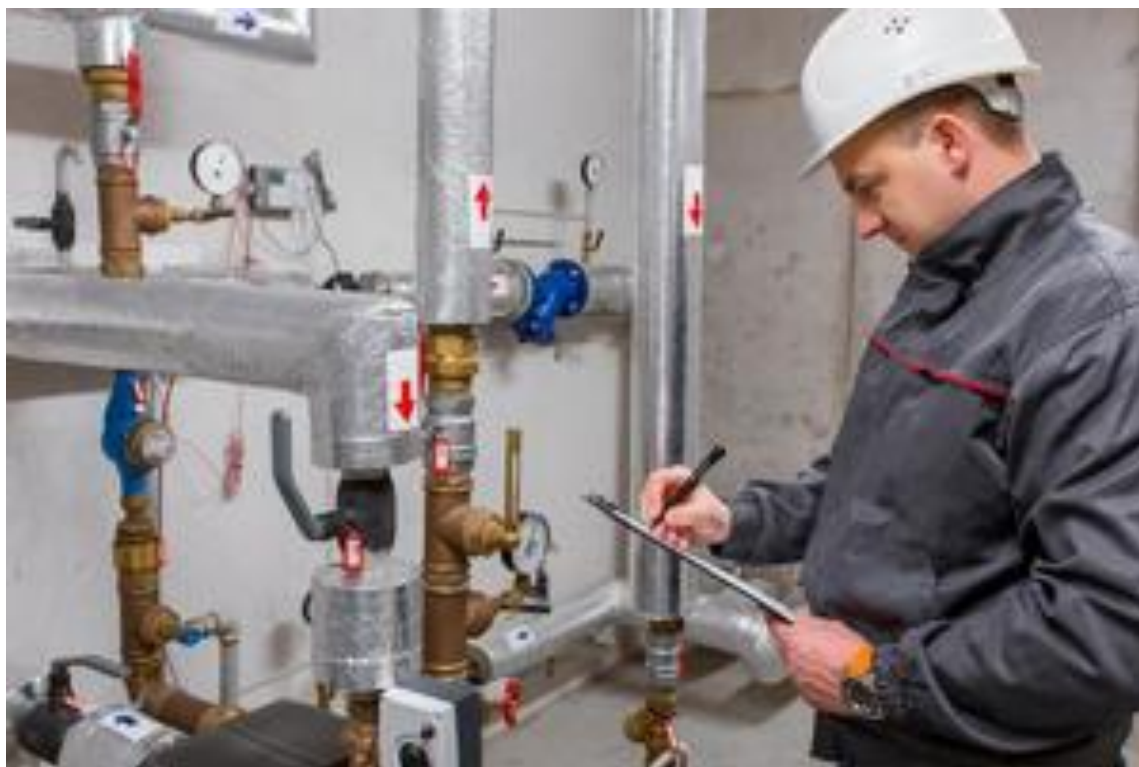
Рисунок 4.4 – Проведення монтажних робіт в тепловому пункті
