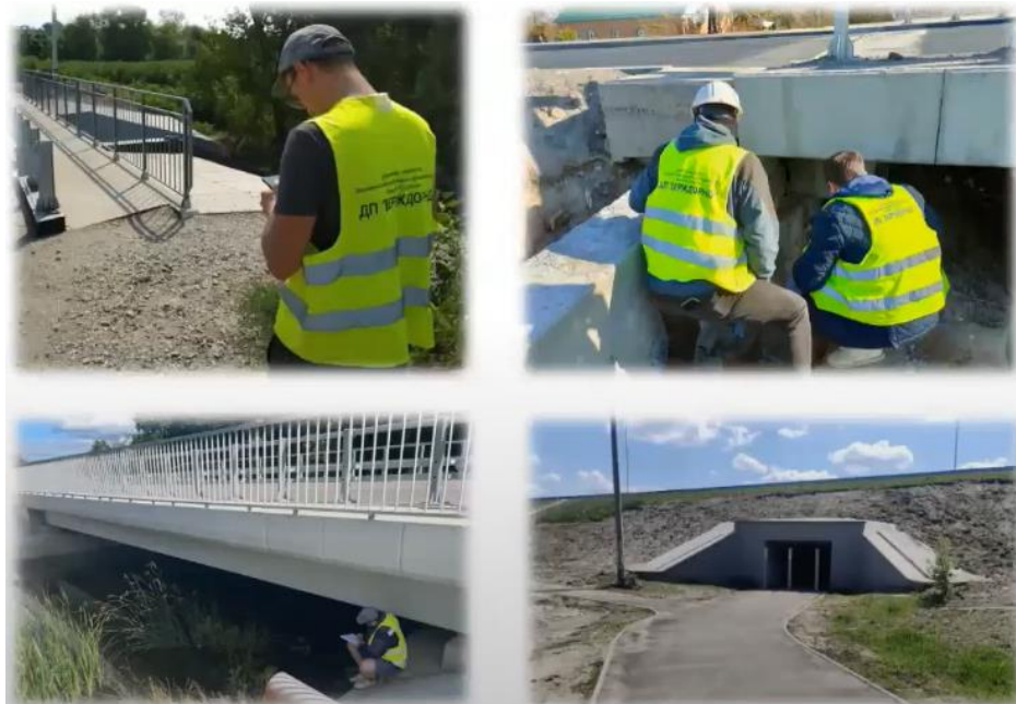
Рисунок 42 – Фото проведення персоналом огляду мостової конструкції [30]
