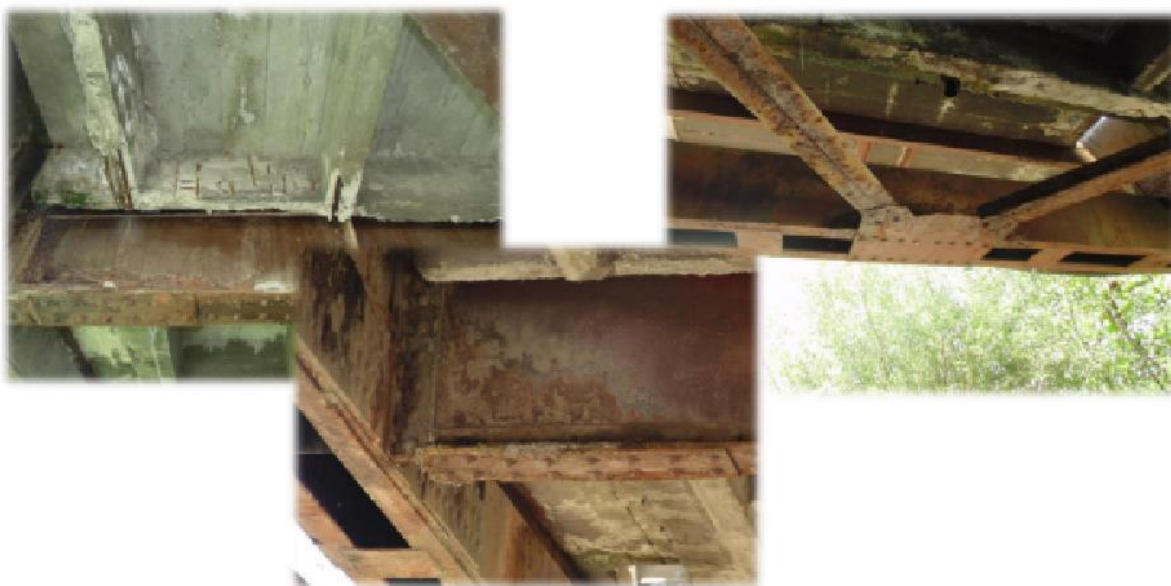
Рисунок 41 – Приклади фрагментів огляду прогонових будов [30]
