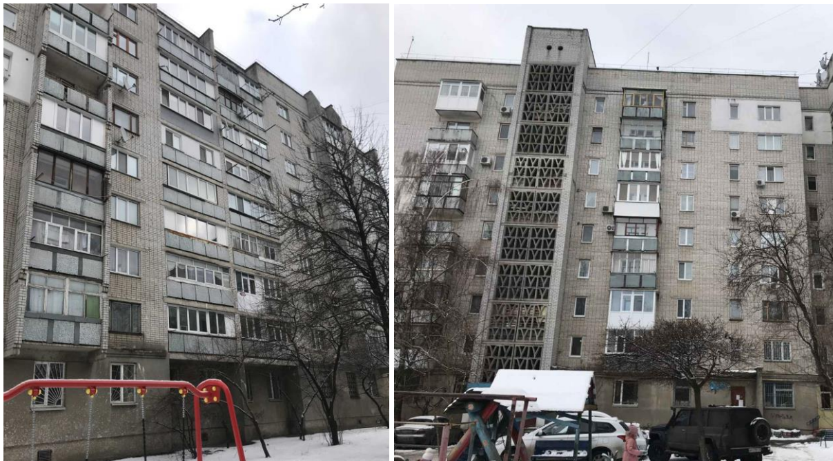
Рисунок 1.3 – Фасади житлового будинку
