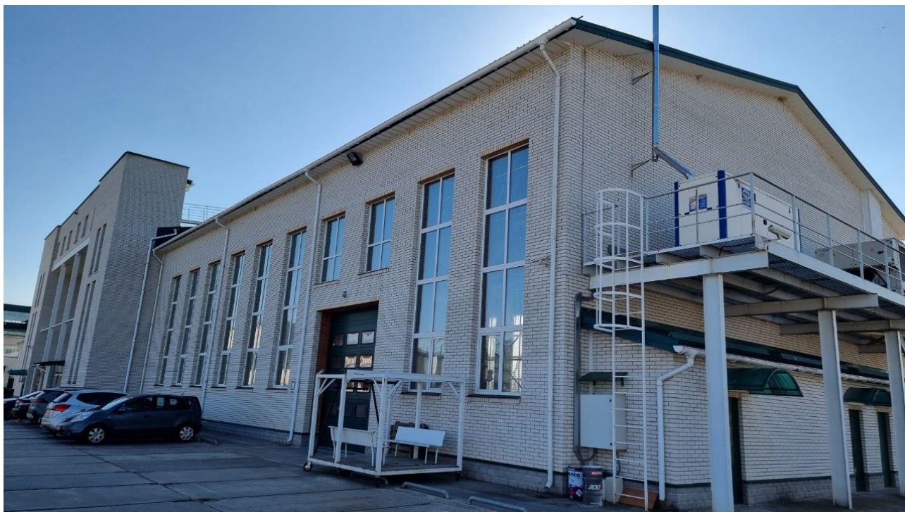
Рисунок 1.1 – Загальний вигляд будівлі
