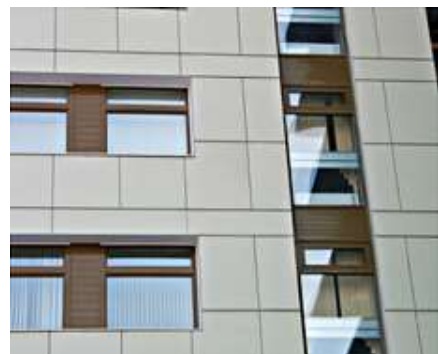
Рисунок 2.1.13 – Утеплення стін за методом "вентильованого фасаду" [32]
