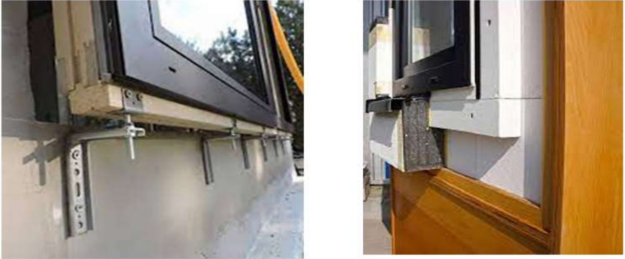
Рис.2.1.21 – Облаштування відкосів при «виносному монтажу» вікон [39]
