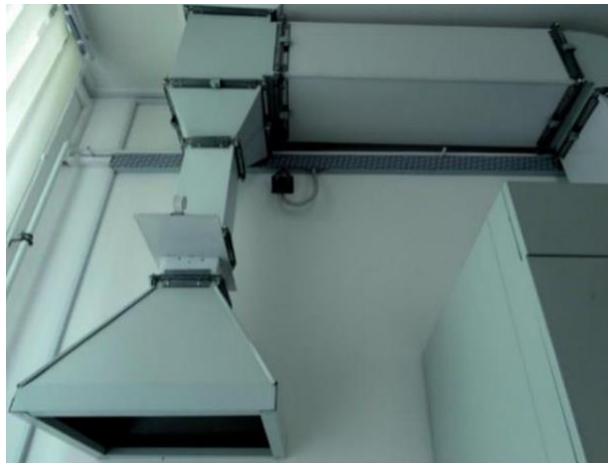
Рисунок 5.2 – Витяжна вентиляція марки С4.65-3.0
