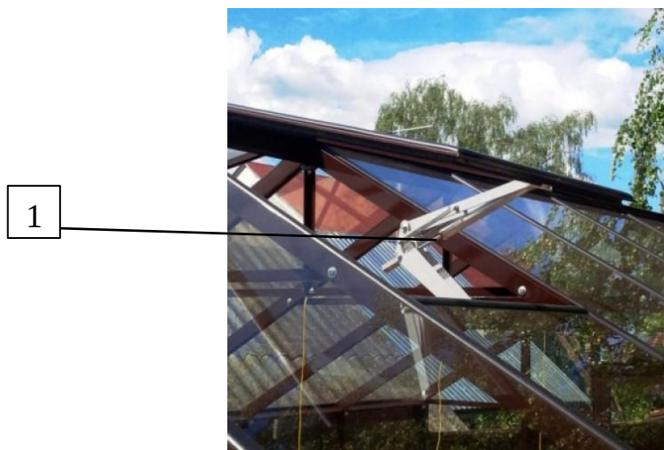
Рисунок 1.7 Приклад автоматичного провітрювання реалізований за допомогою гідро- чи пневмоциліндра 1 [7]
