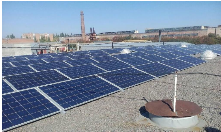
Рисунок 3.7 – Кріплення типу Wind Spoiler після встановлення фотомодолю.
