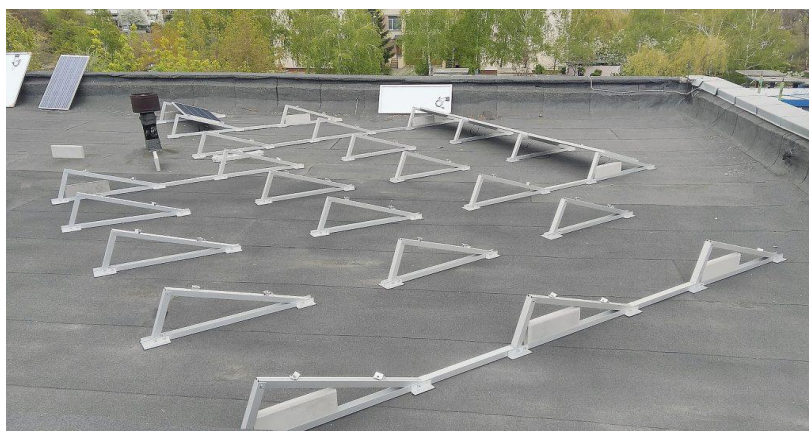
Рисунок 3.6 – Кріплення типу Wind Spoiler до встановлення фотомодюлю.
