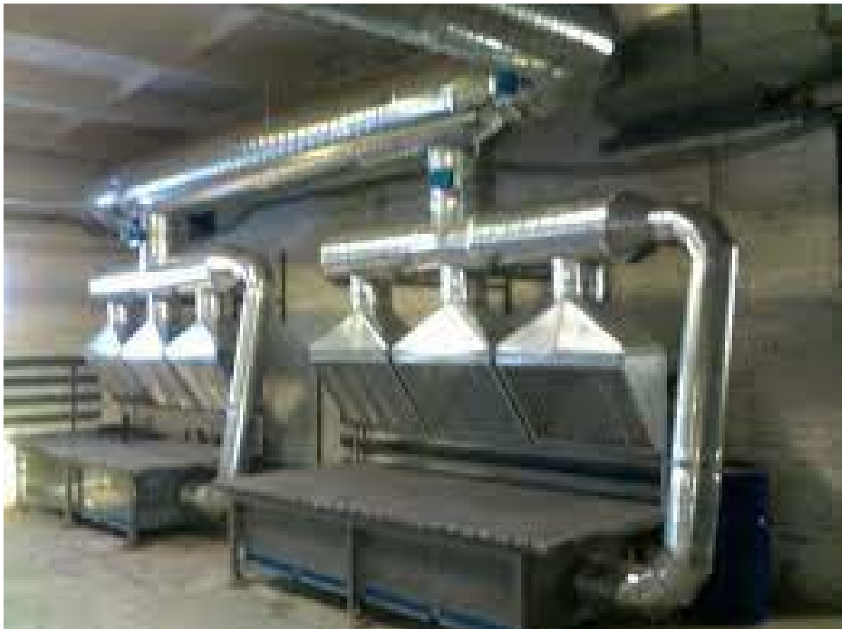
Рисунок 5.2 - Система вентиляції зварювального поста
