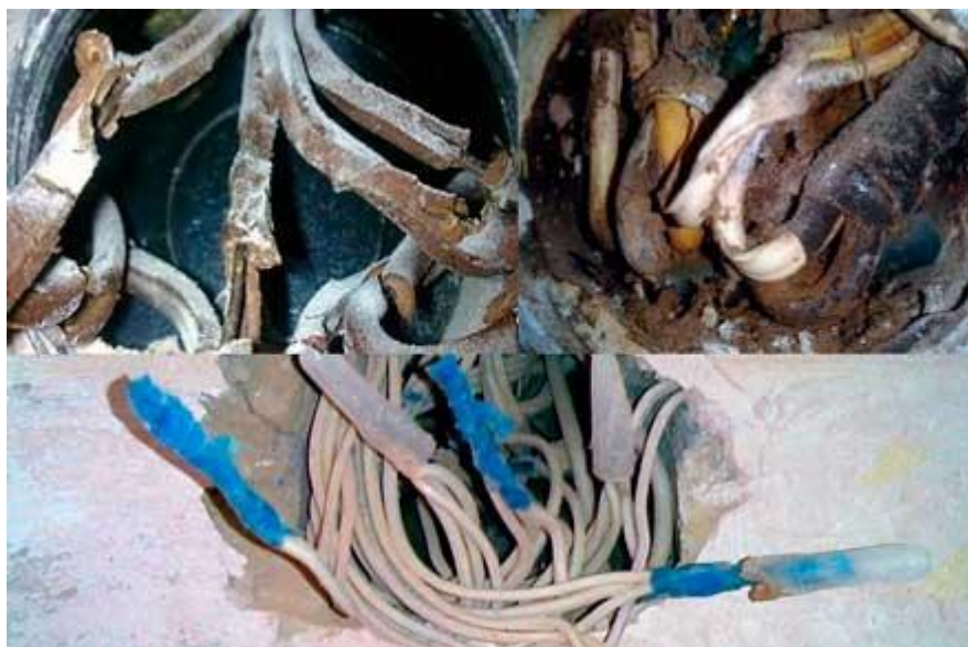
Рисунок 2.3 – Приклад старих кабельних ліній
