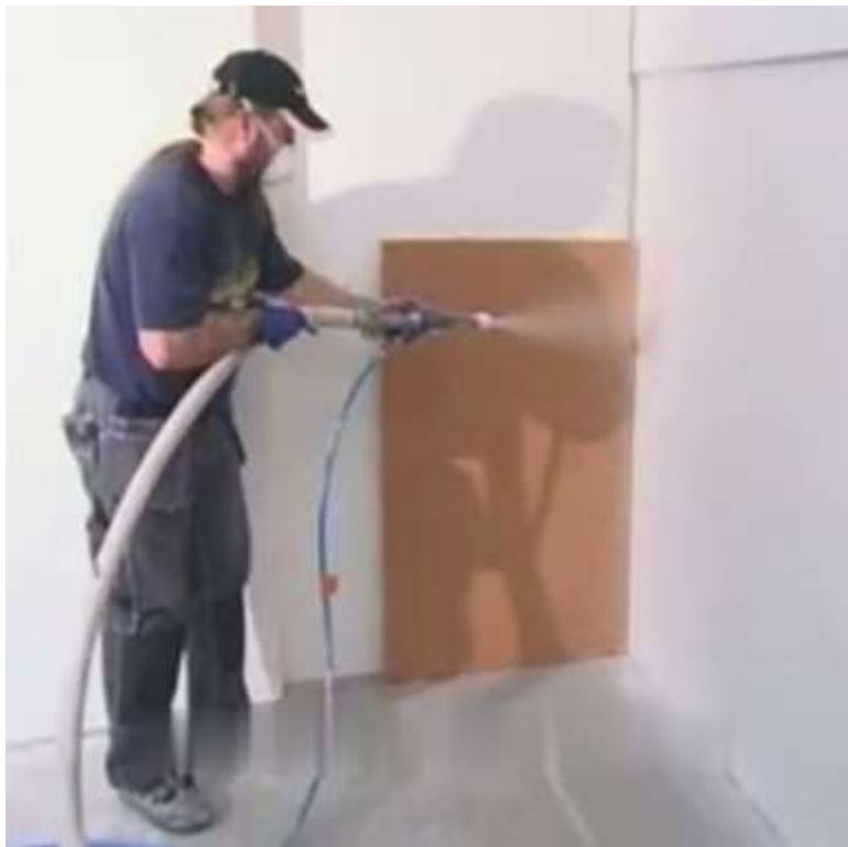
Рисунок 2.5 - Процес нанесення звукопоглинаючого матеріалу Acoustic
