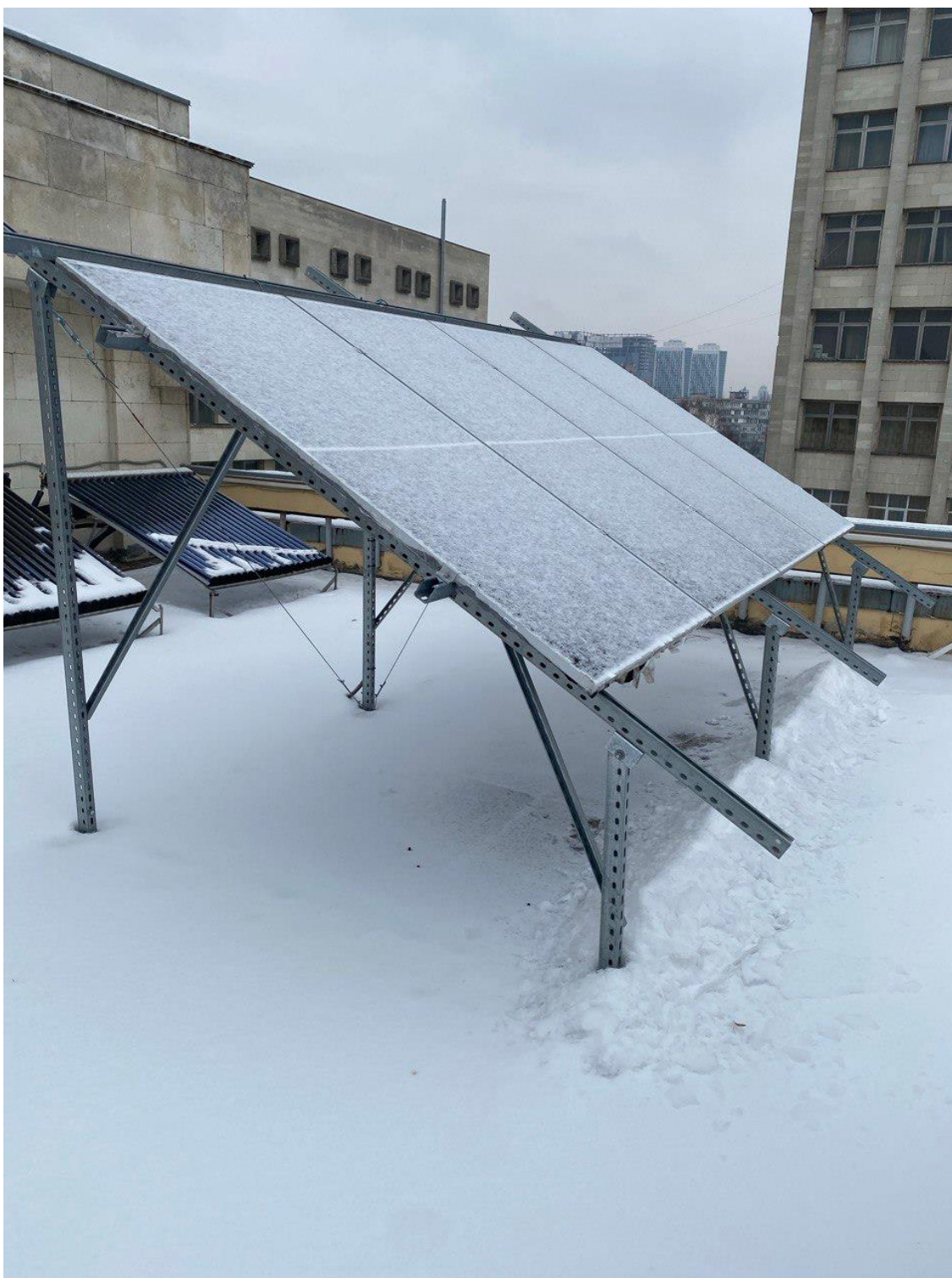
Рисунок 4.20 — Фронтальна поверхня фотомодулів покрита снігом.
