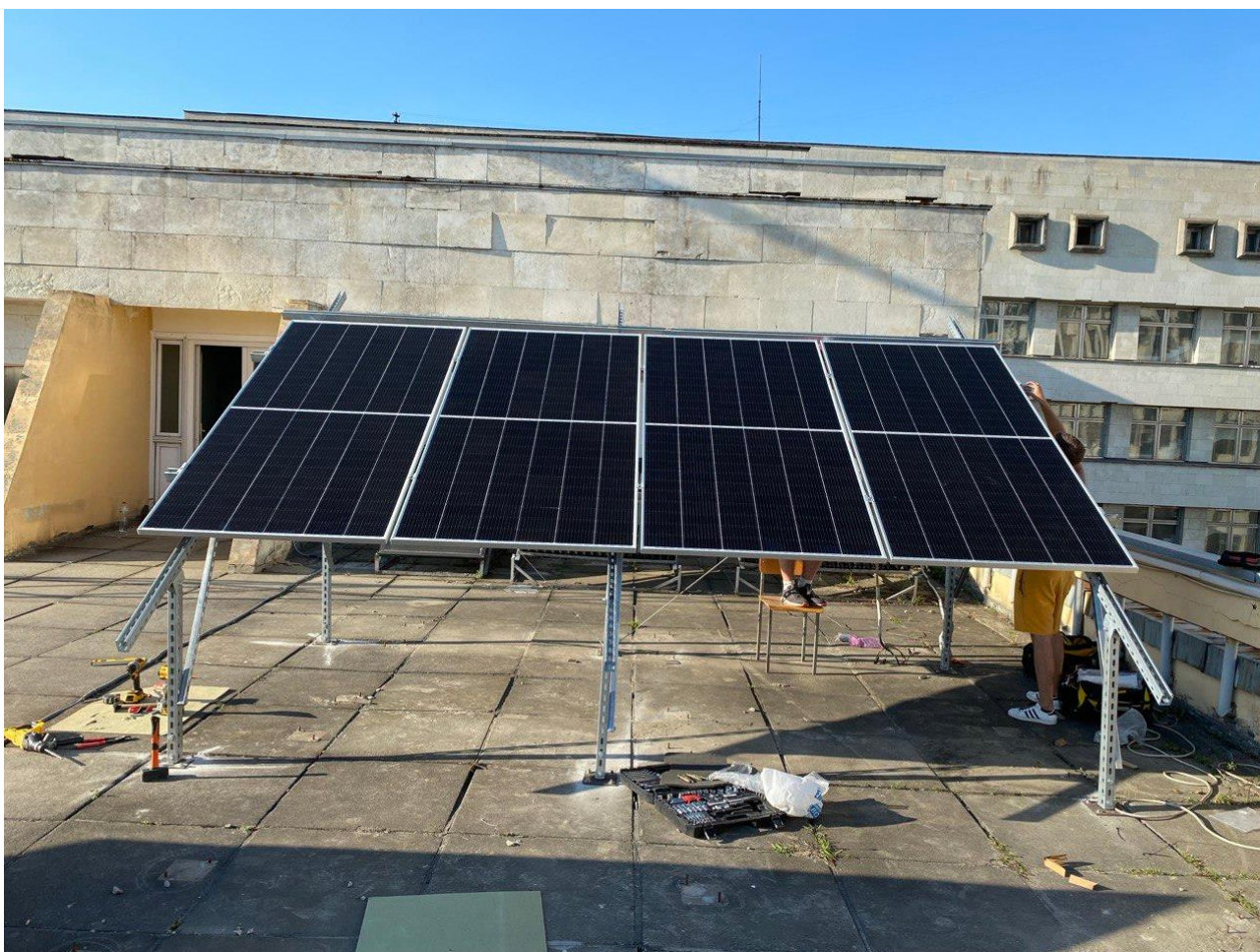
Рисунок 2.2 — Завершальний етап монтажу. Змонтована система кріплень Domino V2-08 та зафіксовані 4-ри фотоелектричні модулі JA Solar JAM72D30-555/GB 555 Wp, Bifacial
