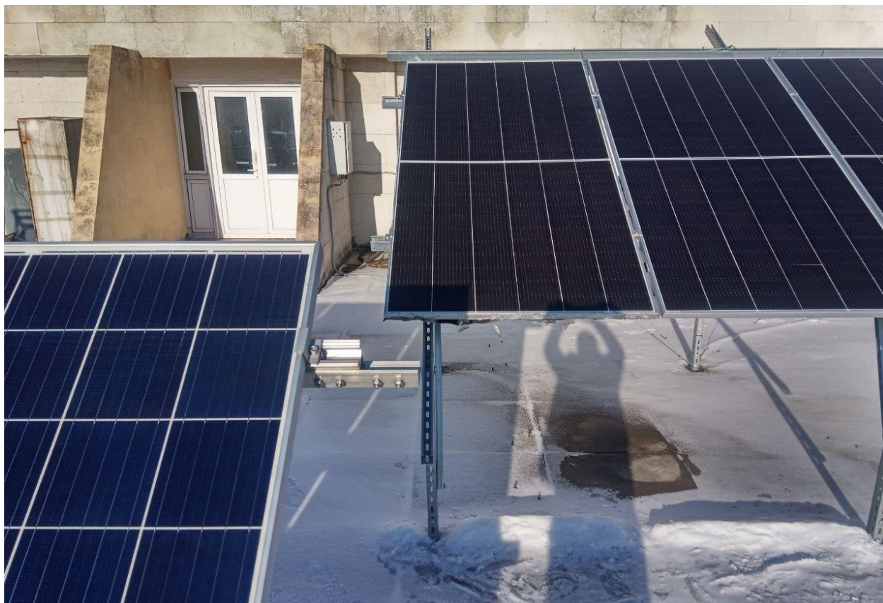
Рисунок 4.19 — Часткове затінення базового стрінгу.
