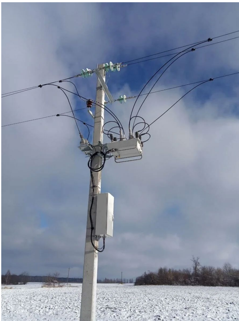
Рисунок 1.2 – Реклоузер на одній опорі [6]
