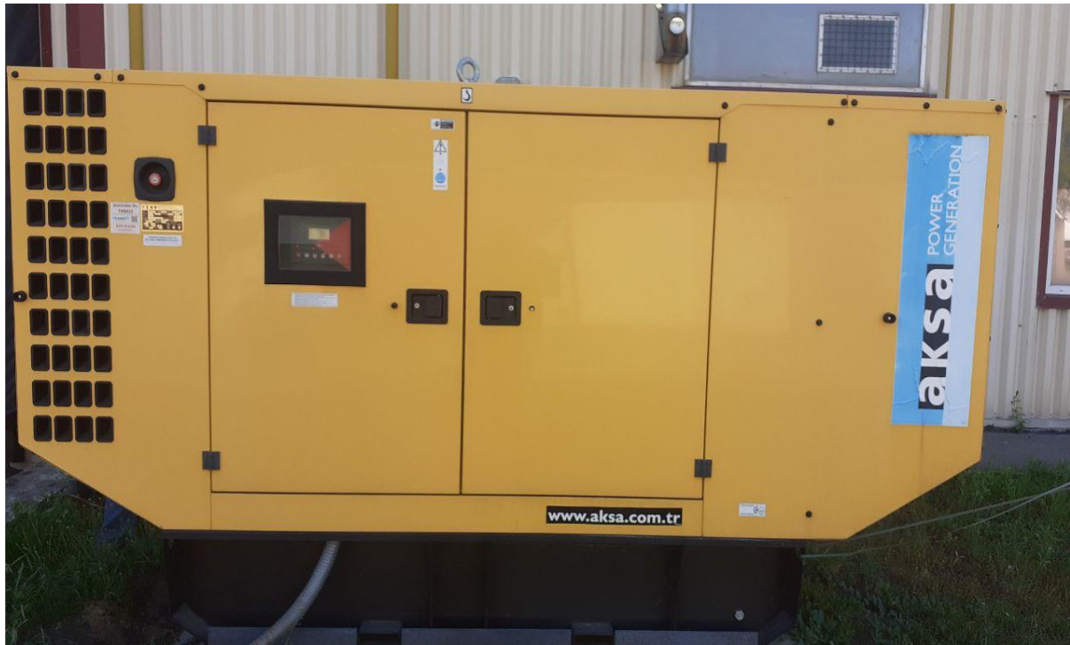
Рисунок 1.4 – Дизельний генератор AKSA моделі AD132
