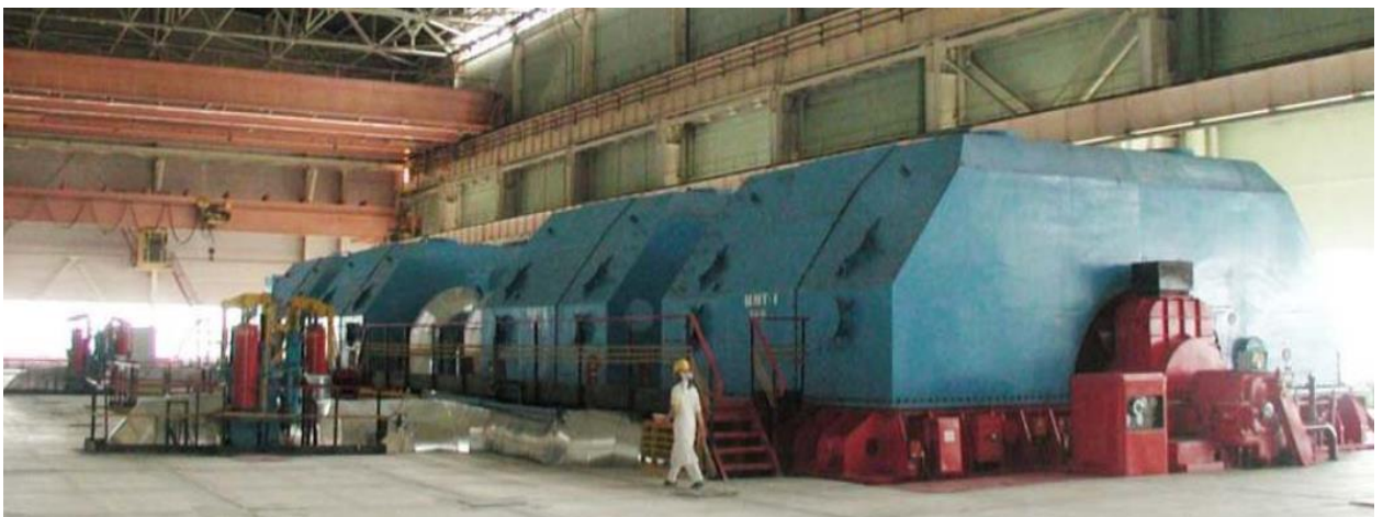
Рис. 2.1. Загальний вигляд турбоустановки К-1000-60/3000
