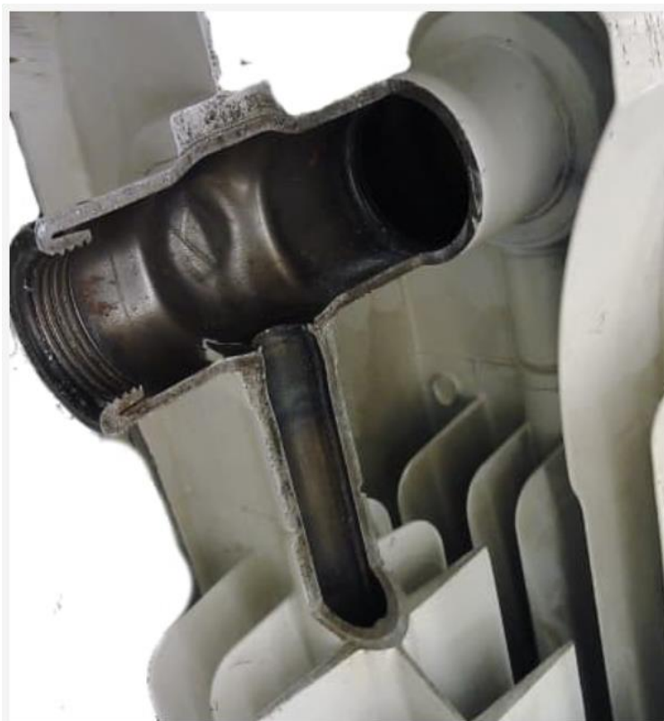
Рисунок 4.2. Біметалевий радіатор в розрізі
