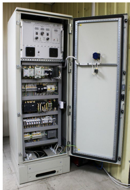
Рисунок 5.16 - Зовнішній вигляд лицьової панелі прототипу джерела живлення (а) та всієї шафи управління в єдиному блоці з джерелом живлення (б, в) прототипу обладнання лазерного зварювання із супутнім мікроплазмовим підігрівом
