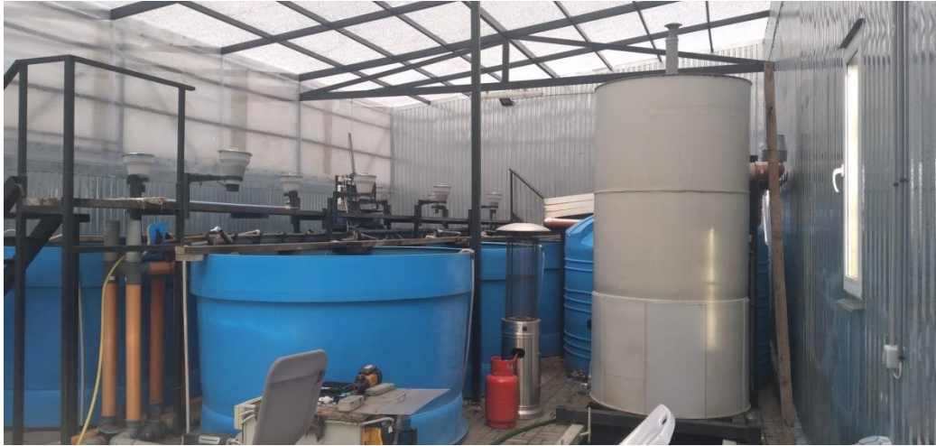
Рисунок 5.2 – Система водопостачання з багаторазовим використанням відпрацьованої води
