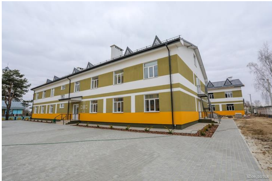
Рисунок 2.1 – Загальний вигляд будівлі
