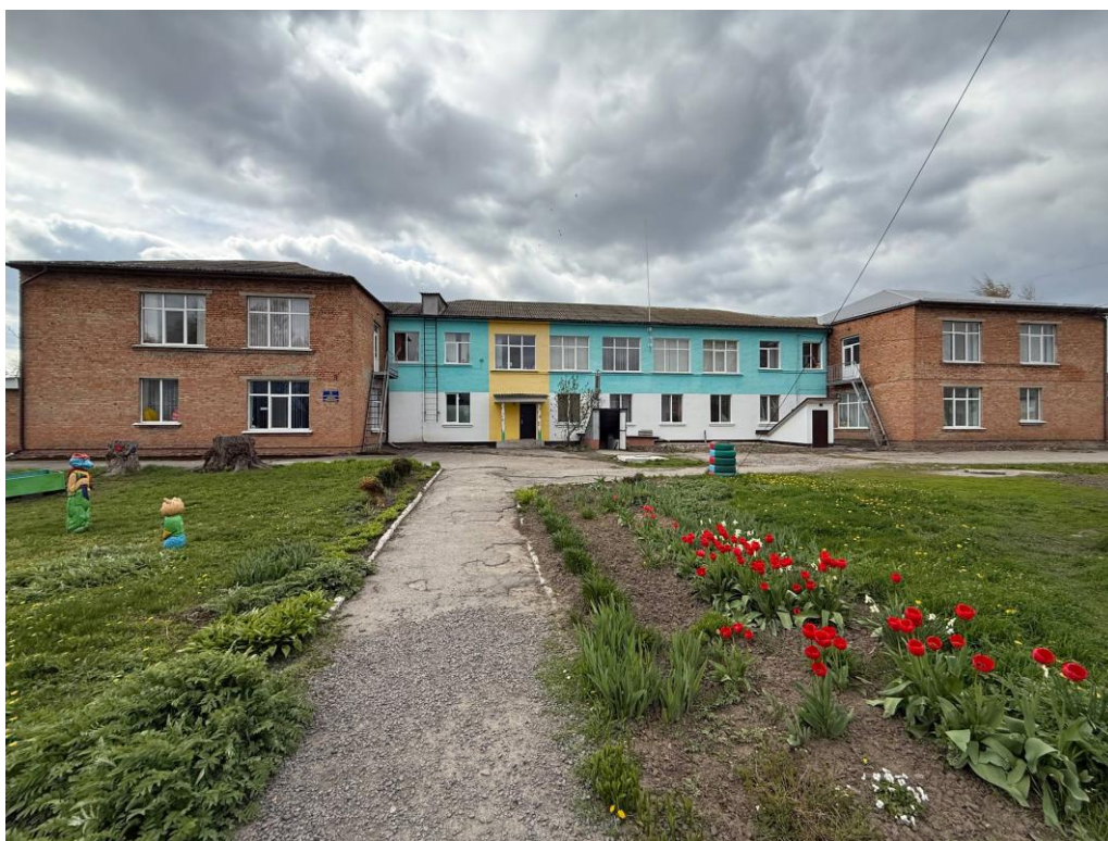
Рисунок 1.1- Вид на будівлю
