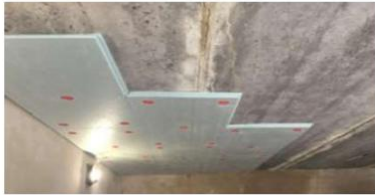
Рисунок 3.5 – Утеплення перекриття підвалу
