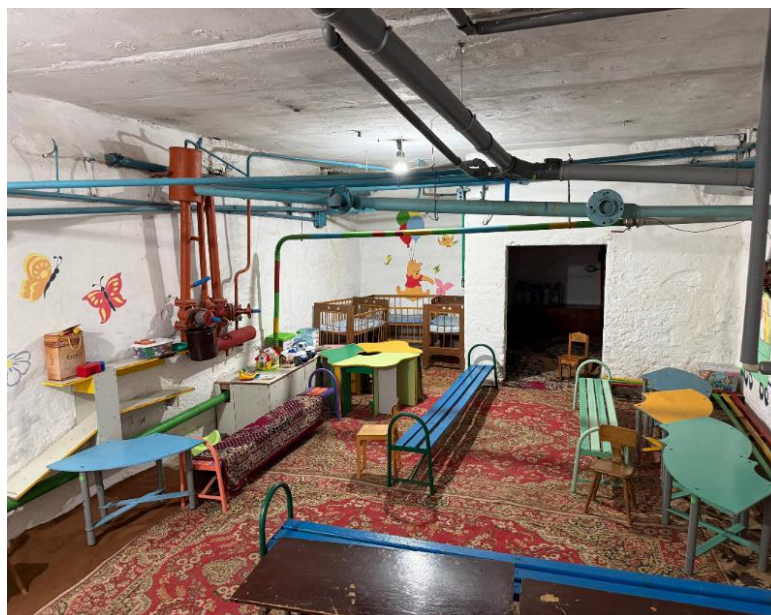
Рисунок 1.4- Підвальне приміщення будівлі
