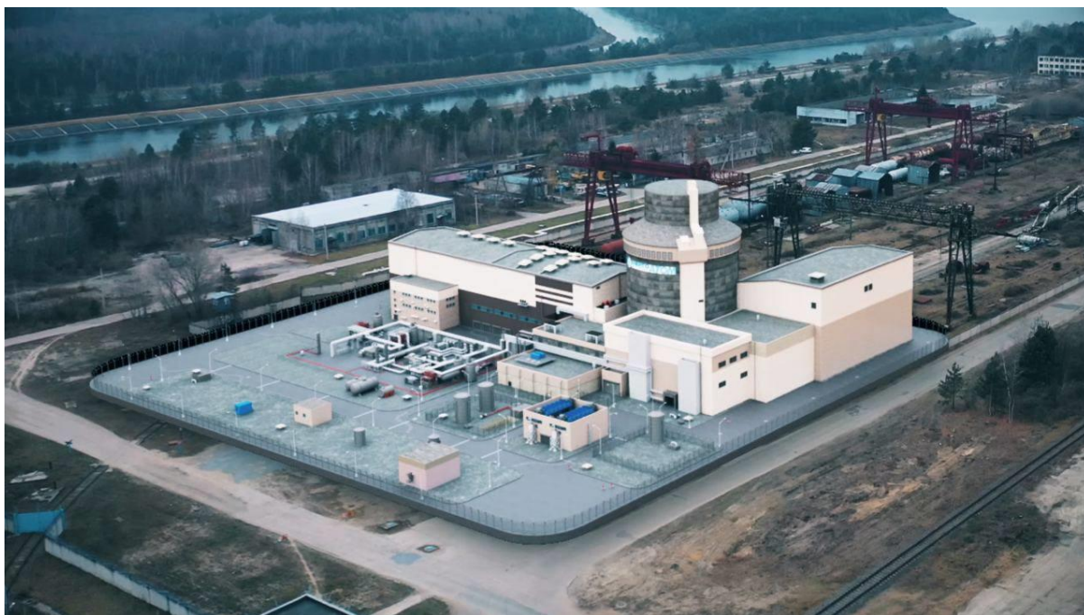
Рисунок 2.8 – Будівництво нових енергоблоків «НАЕК «Енергоатом»
