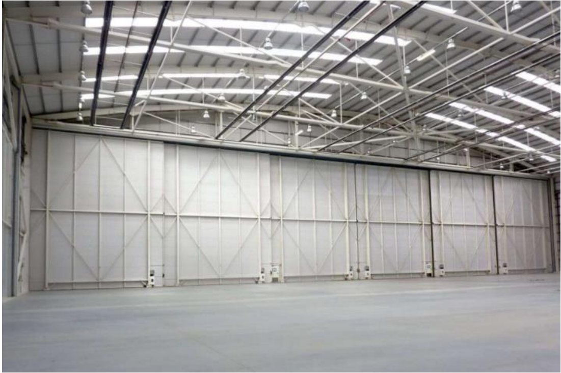
Рис. Загальний вигляд приміщення
