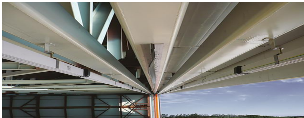
Рис. 1.10 Вигляд напрямних розкатних воріт
