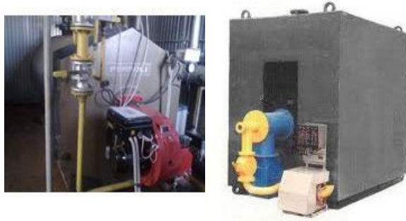
Рисунок 4.1 – Фото водогрійного котла КБНГ-2,5 №3
