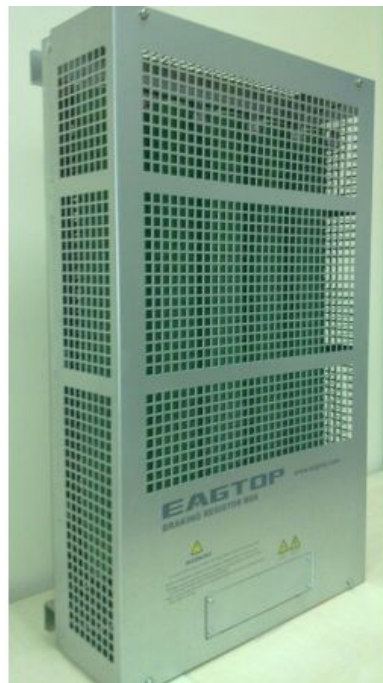
Рисунок 3.18 – Гальмівний резистор для механізму підйому
