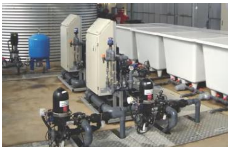
Рис. 1.8. Промислова система крапельного поливу Netafim [12]
