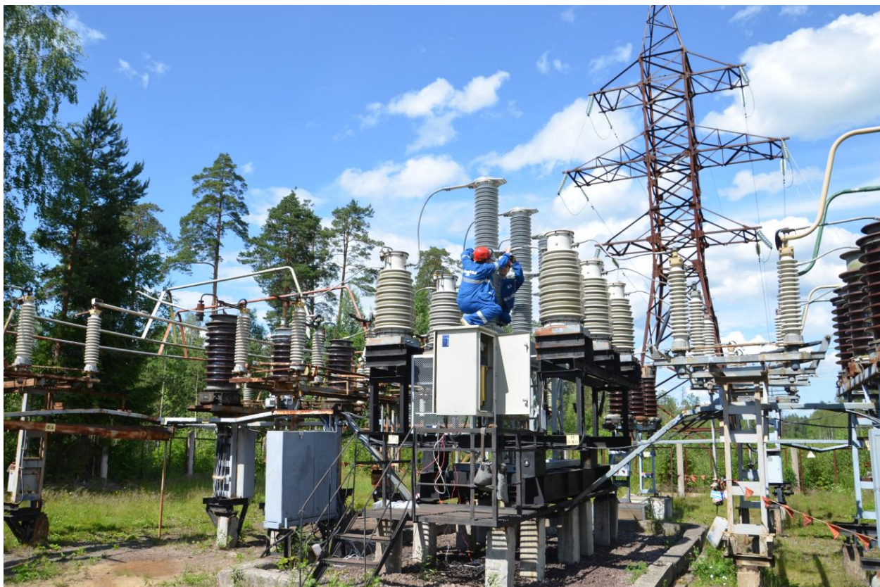
Рисунок 4 – Монтаж вакуумного вимикача зовнішнього встановлення типу ВРС-110 на підстанції 110/10 кВ
