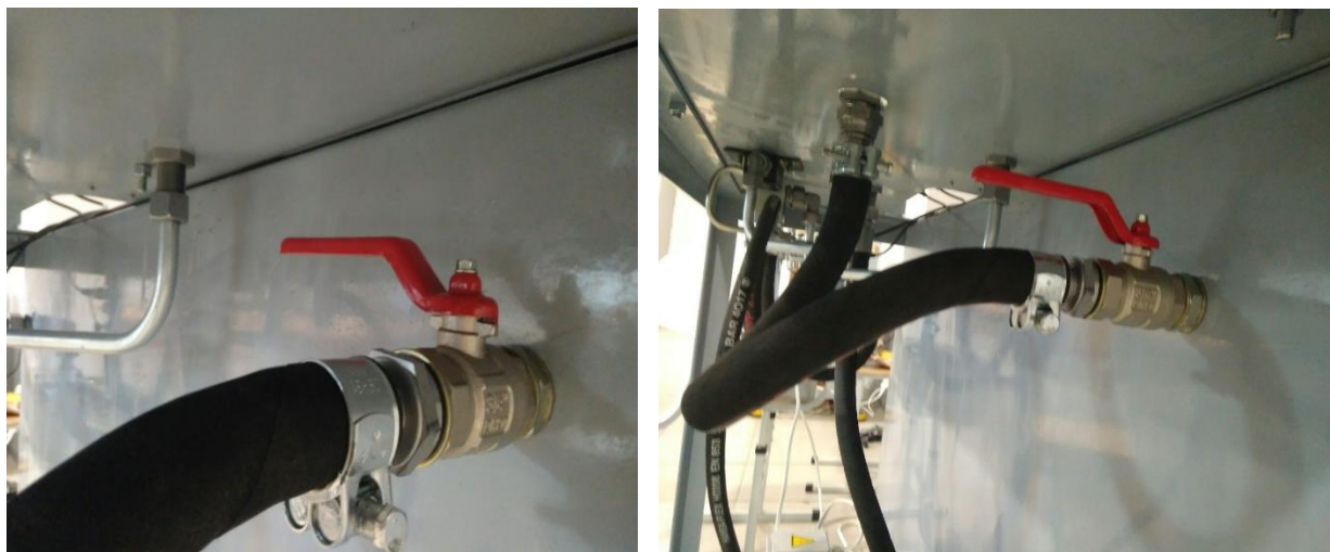
Рис.2.25 Положення ручки крана.
