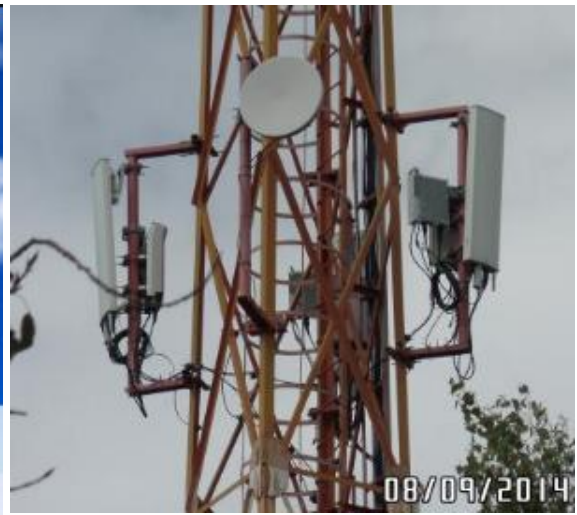
Рис. 6.1 – Антена БС встановлена на вишці
