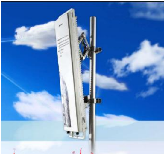
Рис. 6.1 – Антена БС встановлена на вишці
