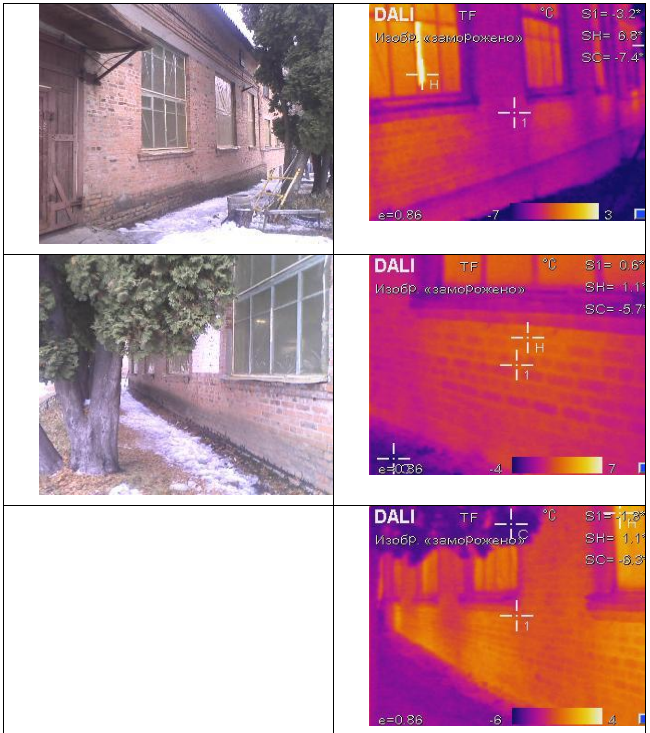
Рисунок 3.5 - Тепловізійне обстеження огорожувальних конструкцій зовні
