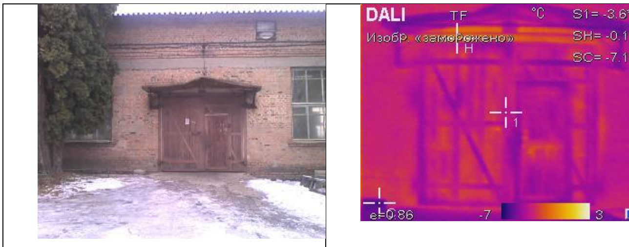
Рисунок 3.1 - Тепловізійне обстеження стіни будівлі з вхідними дверима
